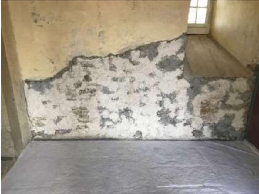
Nach Auftragen des Vorspritzmörtel werden die Hohlstellen und Schlitze mit Stopfmörtel ausgefüllt (helle Flächen).
