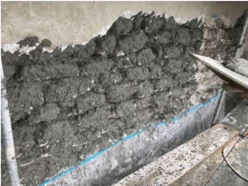
Danach wird der Vorspritzmörtel von Hand aufgespritzt.
