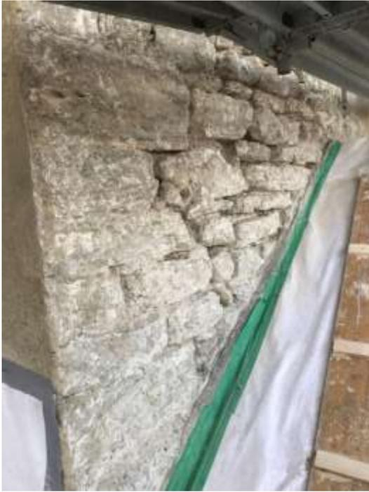
Zuerst wird der alte, mürbe Putz abgespitzt und die Mauerfugen werden freigelegt.
