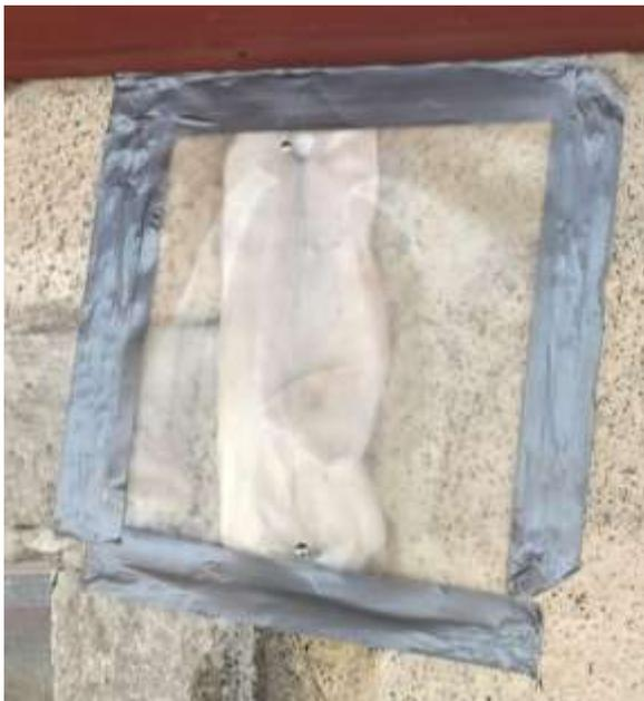
Auch die mit Grundputz gefüllten Risse werden punktuell mit Stabwindeln und Plastik abgedeckt und regelmässig befeuchtet.
