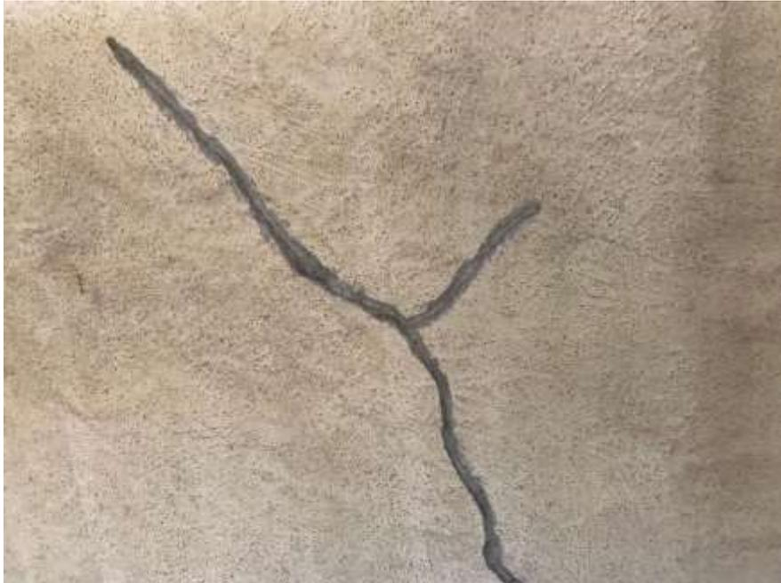
An gewissen Stellen werden nur die bestehenden Risse bearbeitet. D. h. die Risse werden nur örtlich zuerst freigelegt und anschliessend mit Putzmörtel gestopft.
