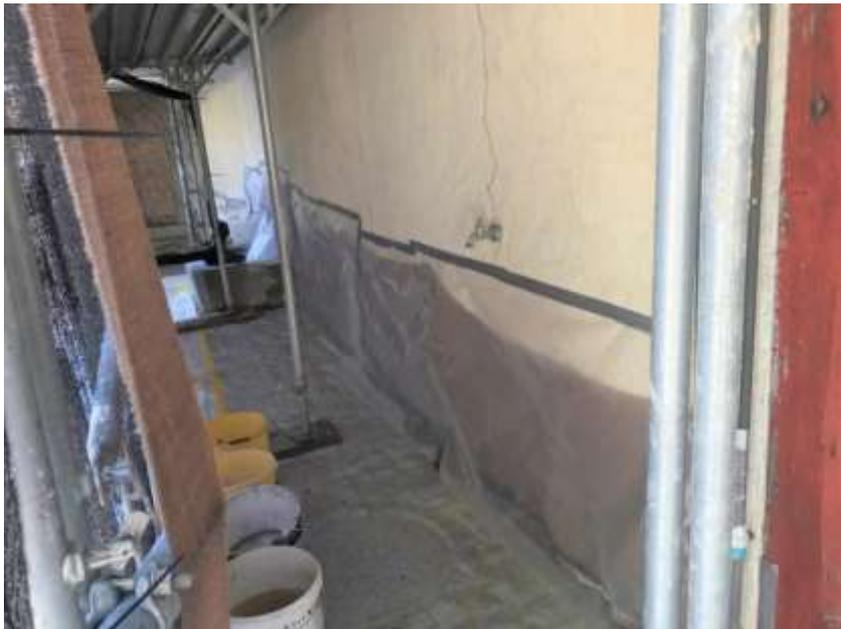
Hier wird nebst der benetzten Jute am Gerüst auch die Fassade mit Jute plus Plastik abgedeckt und regelmässig während 14 Tagen befeuchtet.
