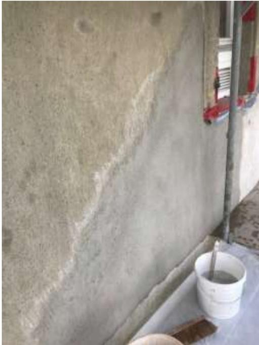
Nach der Trocknungszeit wird an der Fassade punktuell der Finish-Deckputz, bestehend aus 8mm Korn, aufgetragen und mit einem Naturschwamm und diversen Bürsten strukturell an die bestehende Fassade angepasst.
