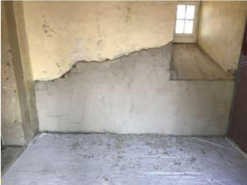
Nach Auftragen des Stopfmörtels folgt die erste Grundputzschicht.
