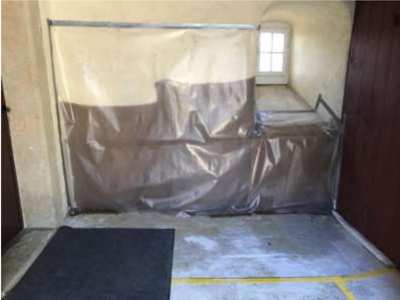
Dieses Bild zeigt einen zurückversetzten Teil der Fassade, welcher mit Jute plus Plastik abgedeckt ist. Die Jute wird regelmässig während 14 Tagen befeuchtet.
