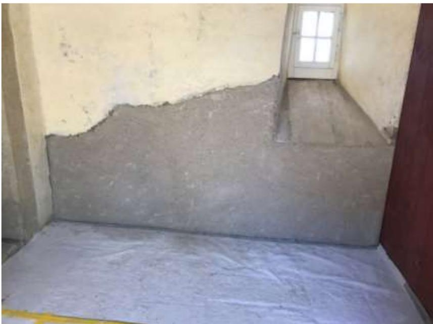
Nach kurzer Abbindezeit wird der Grundputz aufgekratzt.
